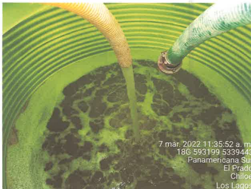
Fotografía N°2: Extracción de Lixiviados a estanque de acumulación. Tomada: Lunes 07 de Marzo del 2022.
