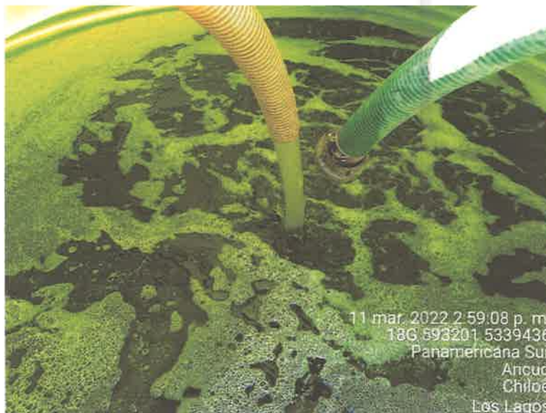
Fotografía N°11: Retiro de Lixiviados a estanque por personal municipal. Tomada: Viernes 11 de Marzo del 2022.
