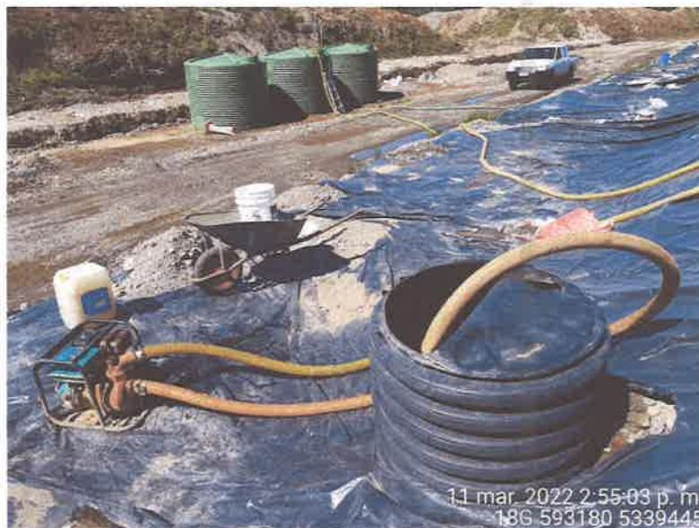
Fotografía N°12: Extracción de Lixiviados por personal municipal. Tomada: Viernes 11 de Marzo del 2022
