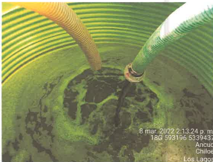
Fotografía N°3: Extracción de Lixiviados por personal municipal. Tomada: Martes 8 de Marzo del 2022.
