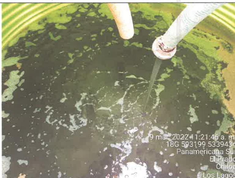
Fotografía N°8: Retiro de Lixiviados a estanque por personal municipal. Tomada: Miércoles 09 de Marzo del 2022
