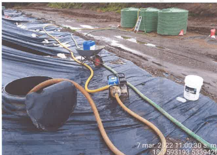
Fotografía N°1: Extracción de Lixiviados desde cámara por personal municipal. Tomada: Lunes 07 de Marzo del 2022.
