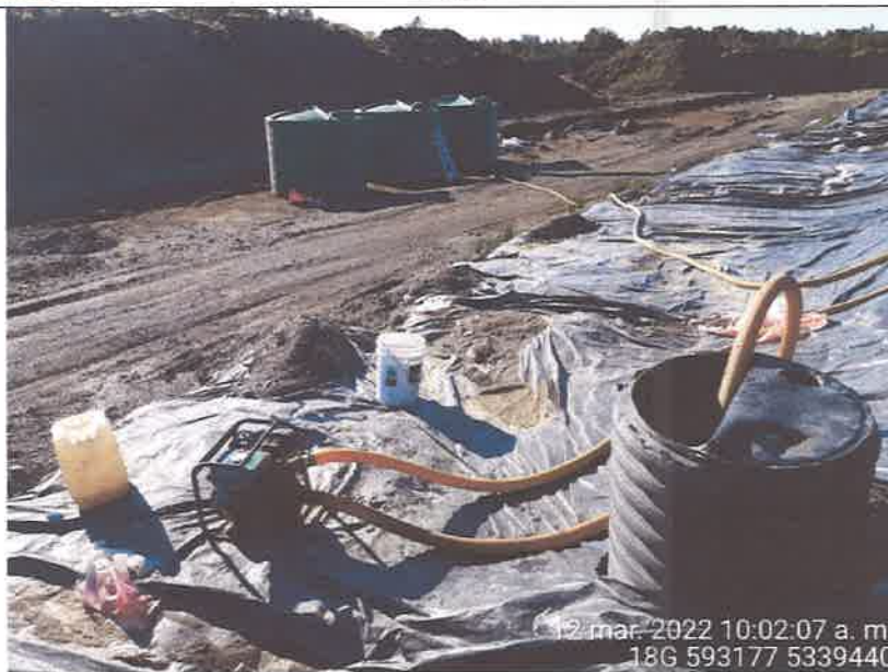
Fotografía N°13: Extracción de Lixiviados por personal municipal. Tomada: Sábado 12 de Marzo del 2022
