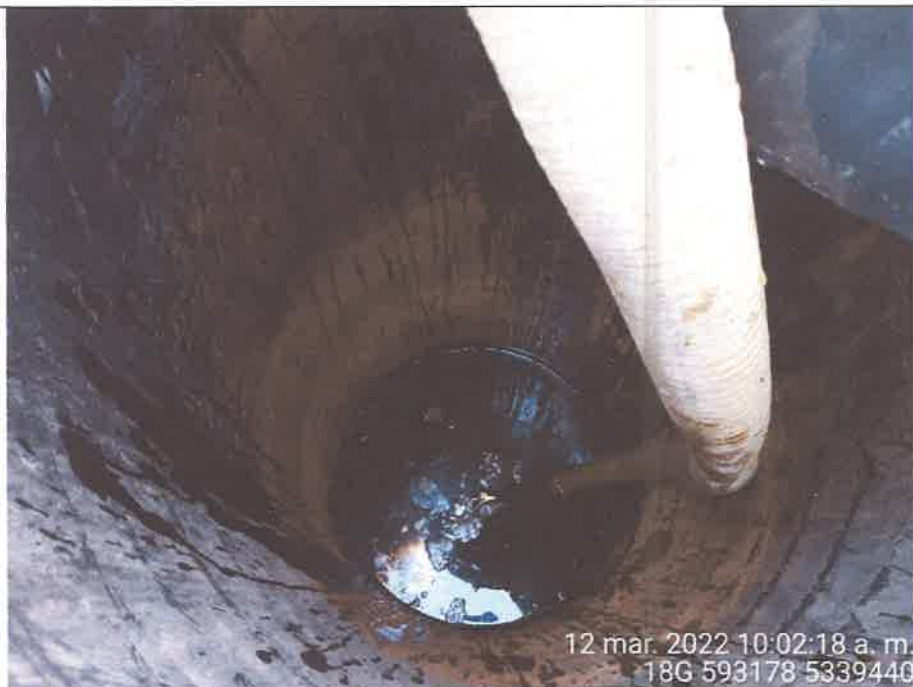
Fotografía N°14: Extracción de Lixiviados por personal municipal. Tomada: Sábado 12 de Marzo del 2022
